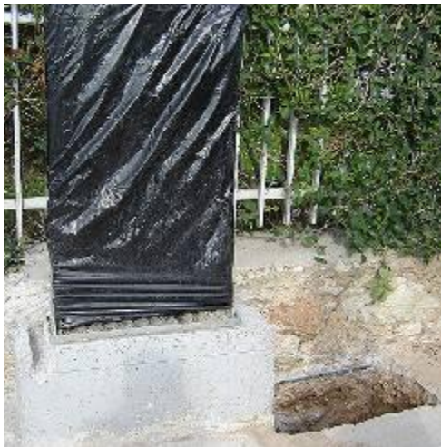
Σχήμα Α9.2.7 Προσαρμογή πλαισίου, εκσκαφή τάφρου επέκτασης, τοποθέτηση οπλισμού
