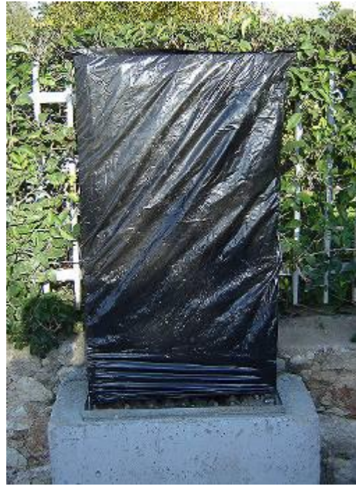
Σχήμα Α9.2.6 Προετοιμασία υφιστάμενου ΚV – Απομάκρυνση Μανδύα και Κάλυψη Κατανεμητή
