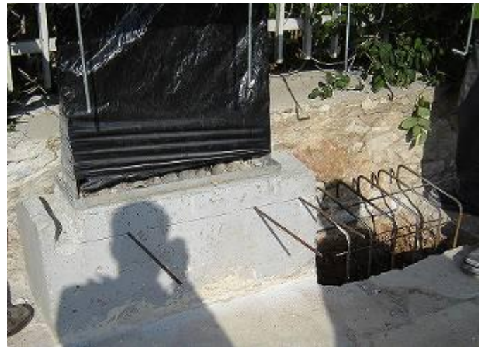
Σχήμα Α9.2.7 Προσαρμογή πλαισίου, εκσκαφή τάφρου επέκτασης, τοποθέτηση οπλισμού
