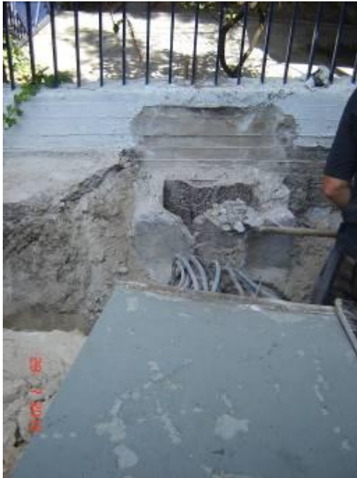
Σχήμα A9.2.13 Καθαίρεση της υφιστάμενης βάσης, προσαρμογή του μεταλλικού πλαισίου, τοποθέτηση οπλισμού
