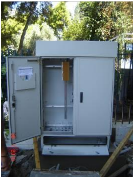
Σχήμα Α9.2.18 Εικόνα καμπίνας Γ3 μετά την ολοκλήρωση των εργασιών τοποθέτησης
