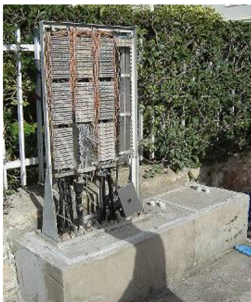
Σχήμα A9.2.10 Αφαίρεση των ξυλοτύπων και τοποθέτηση της καμπίνας στην βάση της
