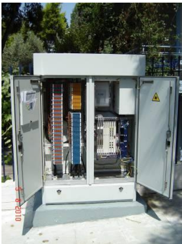
Σχήμα A9.2.22 Τελική κατάσταση εγκατεστημένης καμπίνας Γ3. Δέσιμο των καλωδίων στην μεταλλική βάση στήριξης της καμπίνας Γ3.
