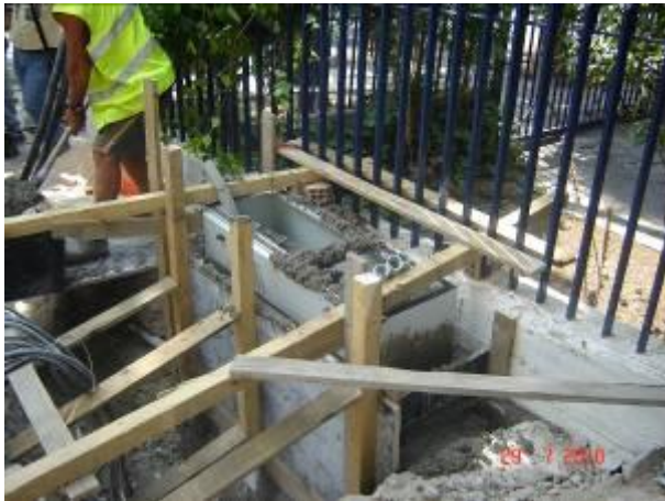
Σχήμα Α9.2.15 Τοποθέτηση ξυλοτύπου, σκυροδέτηση και περίφραξη χώρου υφιστάμενου ΚV
