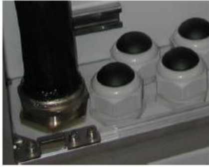
Σχήμα A.9.1.10 Στυπιοθλίπτες στο εσωτερικό καμπίνας
