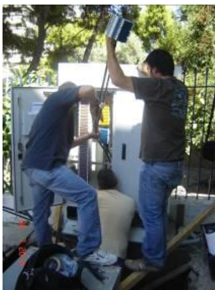
Σχήμα Α9.2.19 Τοποθέτηση του κατανεμητή καλωδίων χαλκού στην καμπίνα Γ3 κατά και μετά την ολοκλήρωση των εργασιών τοποθέτησης
