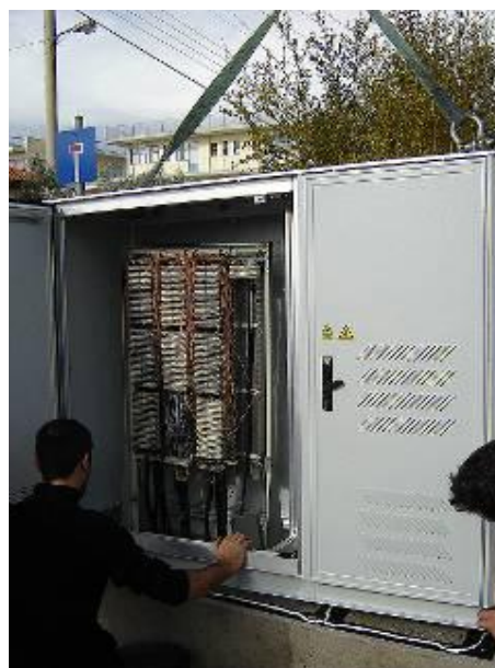
Σχήμα A9.2.10 Αφαίρεση των ξυλοτύπων και τοποθέτηση της καμπίνας στην βάση της
