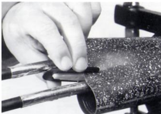
Σχήμα B11.15 Επανατοποθέτηση θερμοσυστελλόμενου σωλήνα και προσαρμογή τριχάλου.
