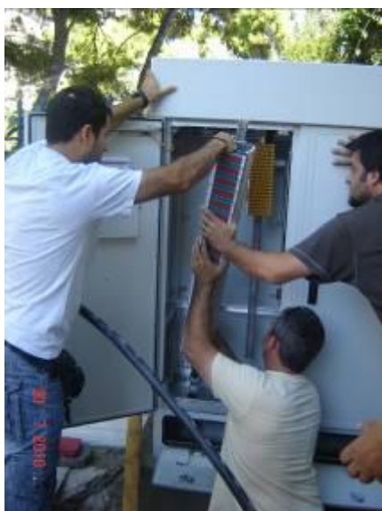
Σχήμα Α9.2.19 Τοποθέτηση του κατανεμητή καλωδίων χαλκού στην καμπίνα Γ3 κατά και μετά την ολοκλήρωση των εργασιών τοποθέτησης
