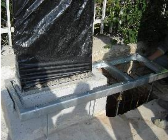
Σχήμα Α9.2.8 Τοποθέτηση μεταλλικού πλαισίου και σωλήνων διέλευσης καλωδίων
