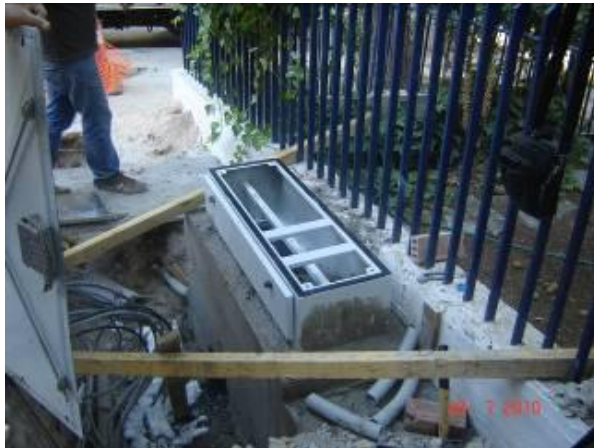
Σχήμα A9.2.17 Αφαίρεση των ξυλοτύπων και τοποθέτηση της καμπίνας στην βάση της
