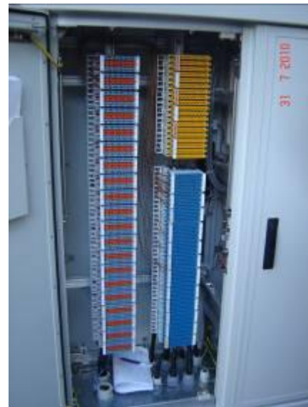
Σχήμα Α9.2.19 Τοποθέτηση του κατανεμητή καλωδίων χαλκού στην καμπίνα Γ3 κατά και μετά την ολοκλήρωση των εργασιών τοποθέτησης
