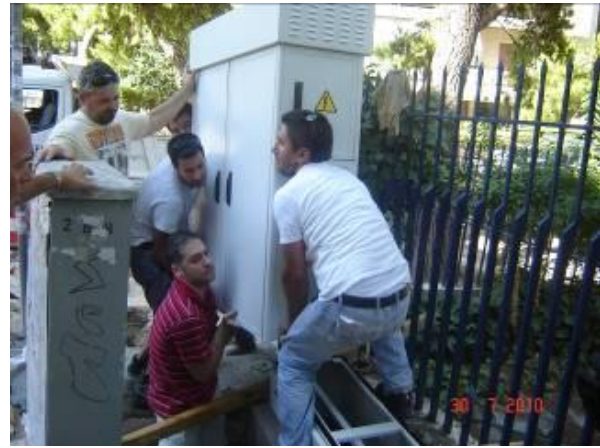
Σχήμα A9.2.17 Αφαίρεση των ξυλοτύπων και τοποθέτηση της καμπίνας στην βάση της
