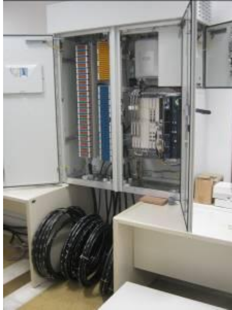
Σχήμα Α9.2.20 Πλήρως προκαλωδιωμένη καμπίνα Γ3 πριν την εγκατάσταση
