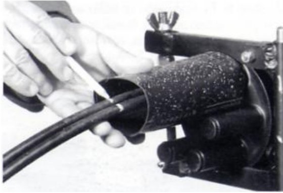
Σχήμα B11.13 Σήμανση άκρων θερμοσυστελλόμενου σωλήνα
