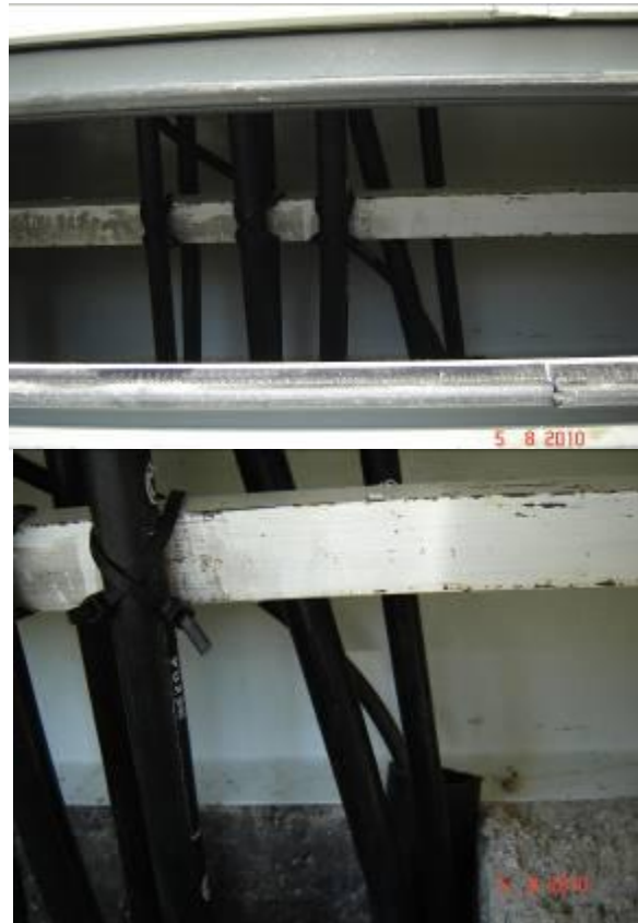
Σχήμα A9.2.22 Τελική κατάσταση εγκατεστημένης καμπίνας Γ3. Δέσιμο των καλωδίων στην μεταλλική βάση στήριξης της καμπίνας Γ3.
