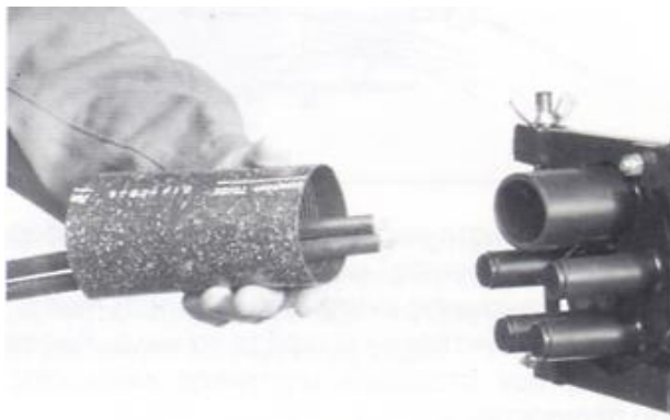
Σχήμα B11.4 Τοποθέτηση θερμοσυστελλόμενου σωλήνα
