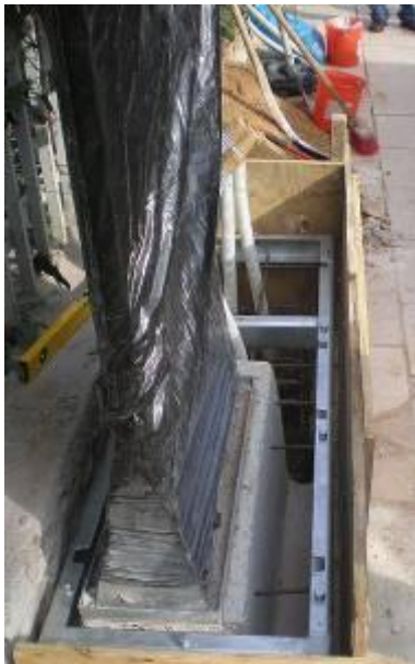
Σχήμα Α9.2.9 Τοποθέτηση ξυλοτύπου, σκυροδέτηση και επανατοποθέτηση μανδύα ΚV
