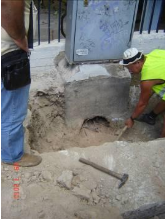
Σχήμα Α9.2.12 α) Εκσκαφή τάφρου περιμετρικά του KV και αποκάλυψη της εισόδου των καλωδίων, β) Μετακίνηση του KV σε κατάσταση λειτουργίας
