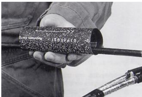
Σχήμα Β11.34 Πέρασμα στρογγυλού θερμοσυστελλόμενου σωλήνα
