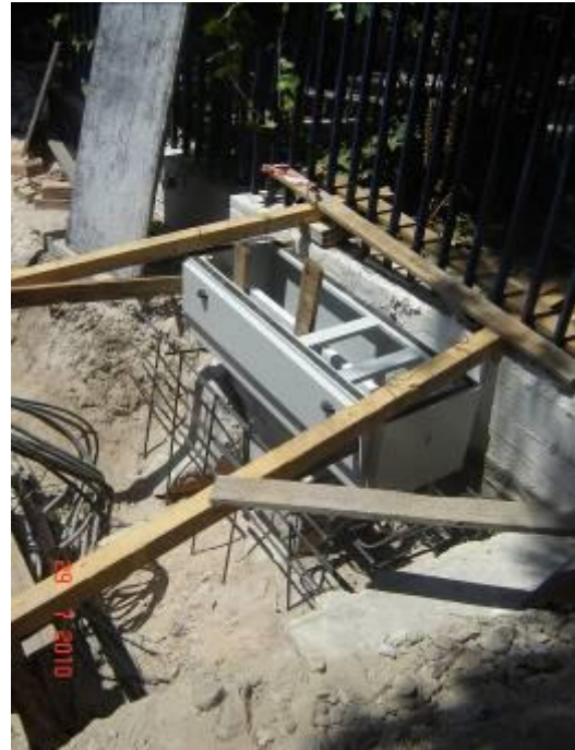
Σχήμα A9.2.13 Καθαίρεση της υφιστάμενης βάσης, προσαρμογή του μεταλλικού πλαισίου, τοποθέτηση οπλισμού
