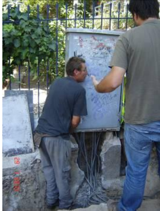
Σχήμα Α9.2.12 α) Εκσκαφή τάφρου περιμετρικά του KV και αποκάλυψη της εισόδου των καλωδίων, β) Μετακίνηση του KV σε κατάσταση λειτουργίας
