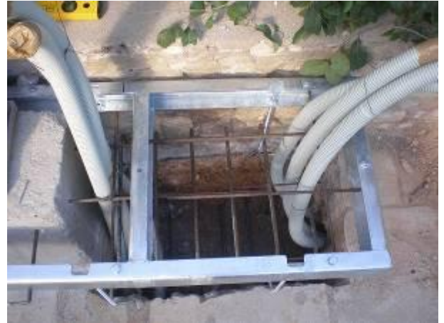
Σχήμα Α9.2.8 Τοποθέτηση μεταλλικού πλαισίου και σωλήνων διέλευσης καλωδίων
