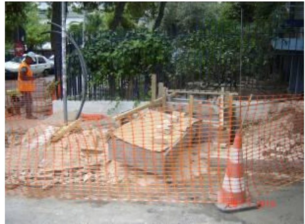
Σχήμα Α9.2.15 Τοποθέτηση ξυλοτύπου, σκυροδέτηση και περίφραξη χώρου υφιστάμενου ΚV
