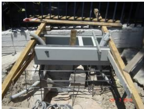
Σχήμα A9.2.14 Τοποθέτηση μεταλλικού πλαισίου και σωλήνων διέλευσης καλωδίων
