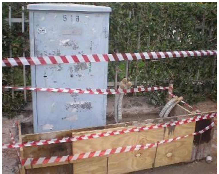
Σχήμα Α9.2.9 Τοποθέτηση ξυλοτύπου, σκυροδέτηση και επανατοποθέτηση μανδύα ΚV
